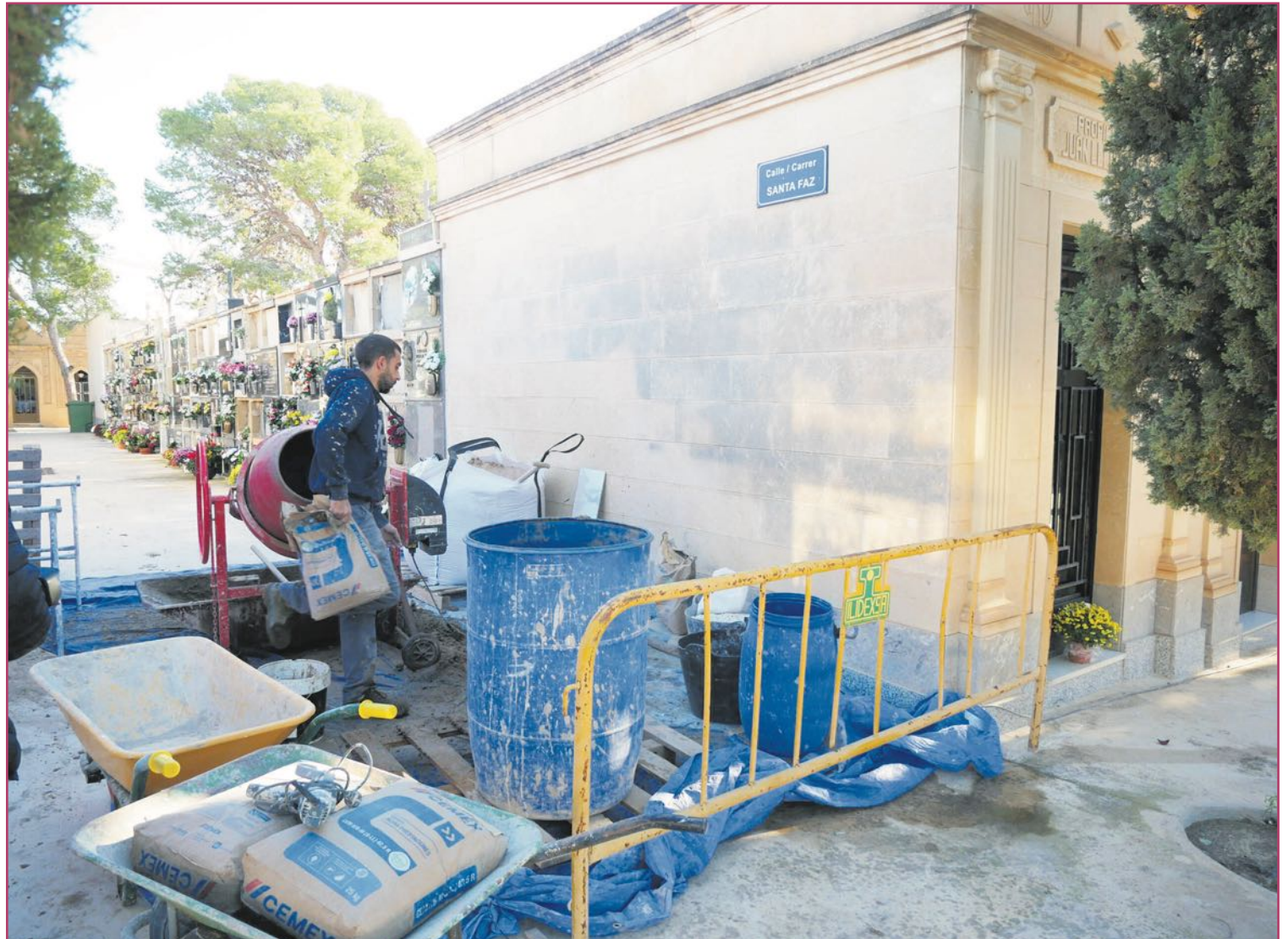
Obras en el cementerio municipal.
