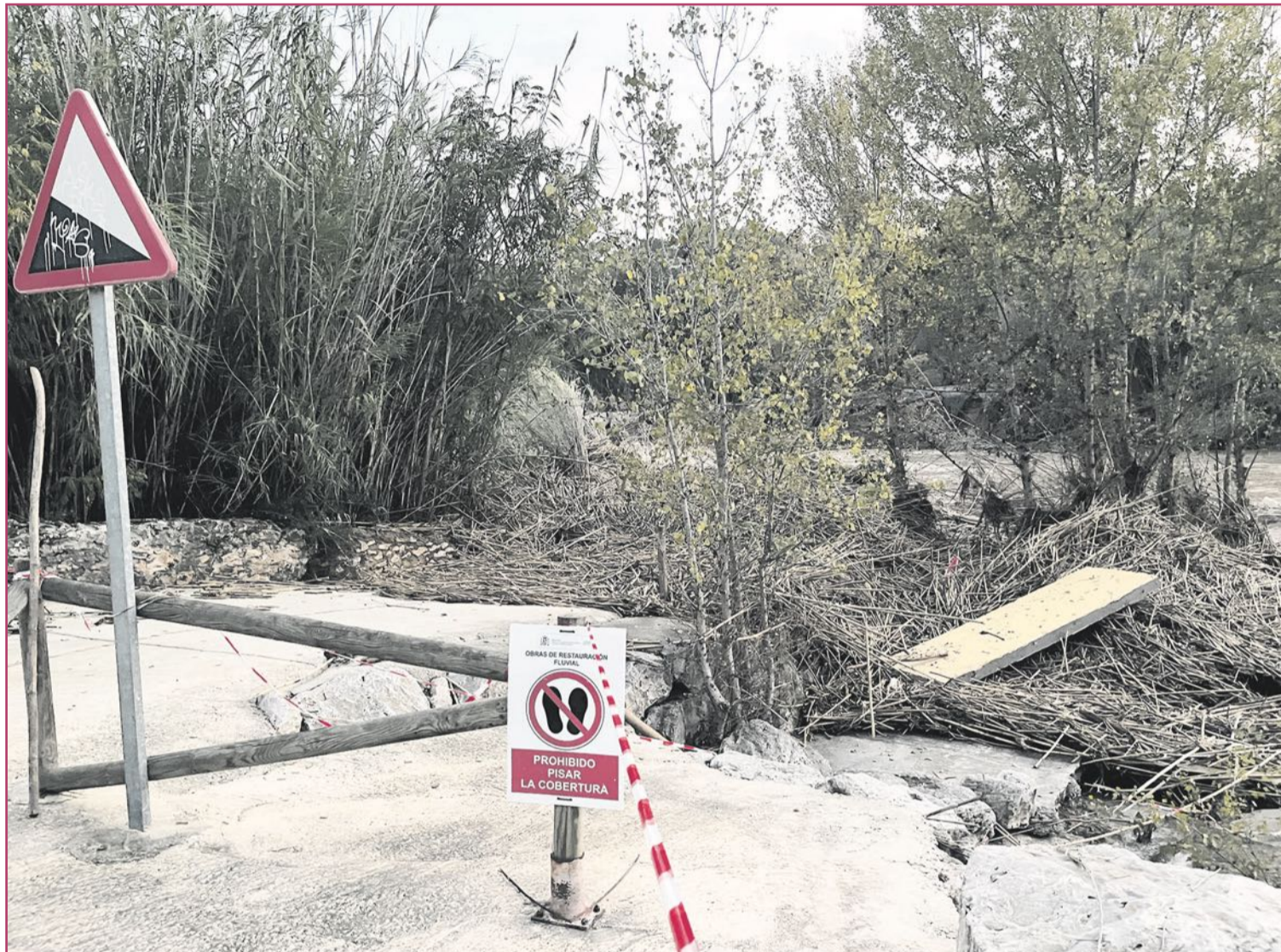
Acceso cortado a los alrededores del Turia, a la altura de Manises.
