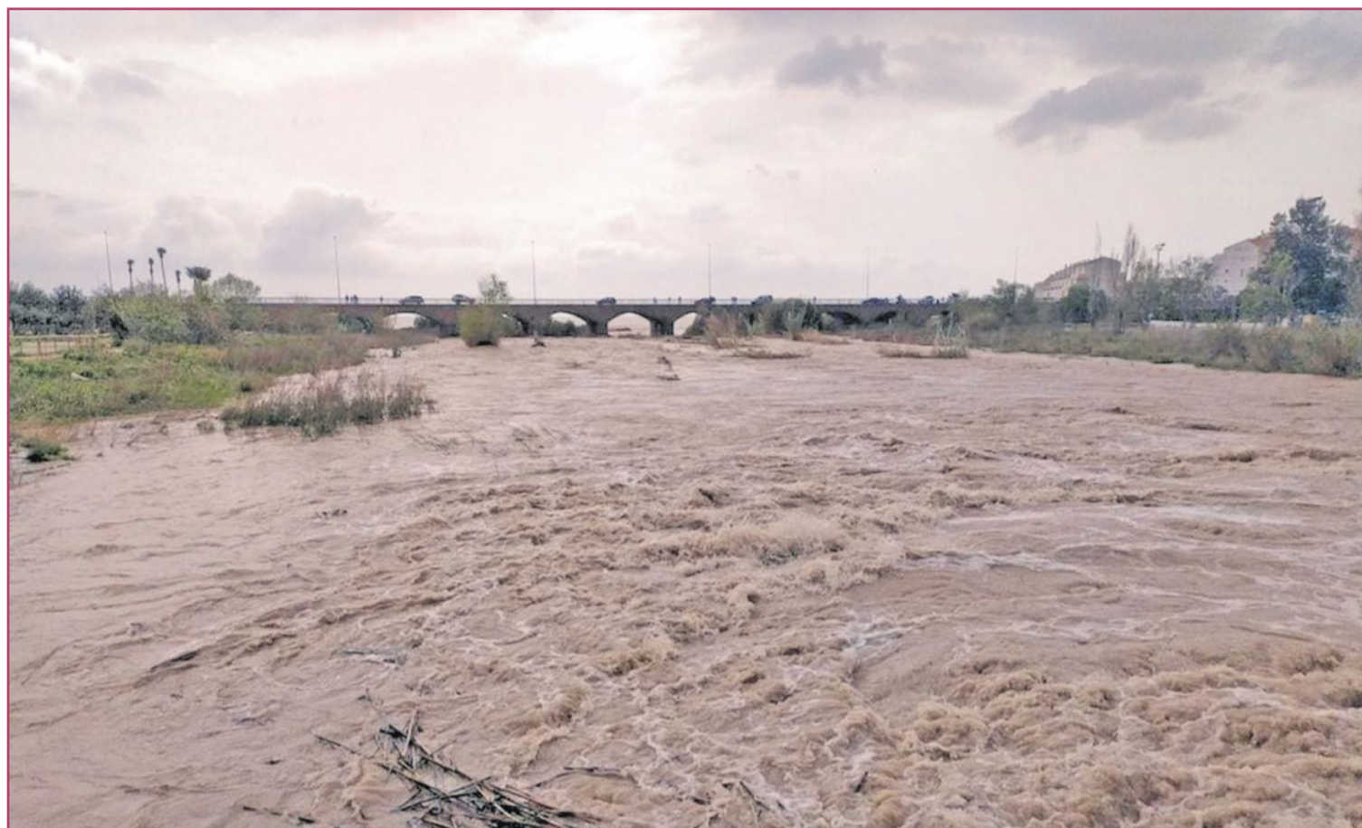
Así bajaba el río Algar en Altea tras unas lluvias torrenciales.
