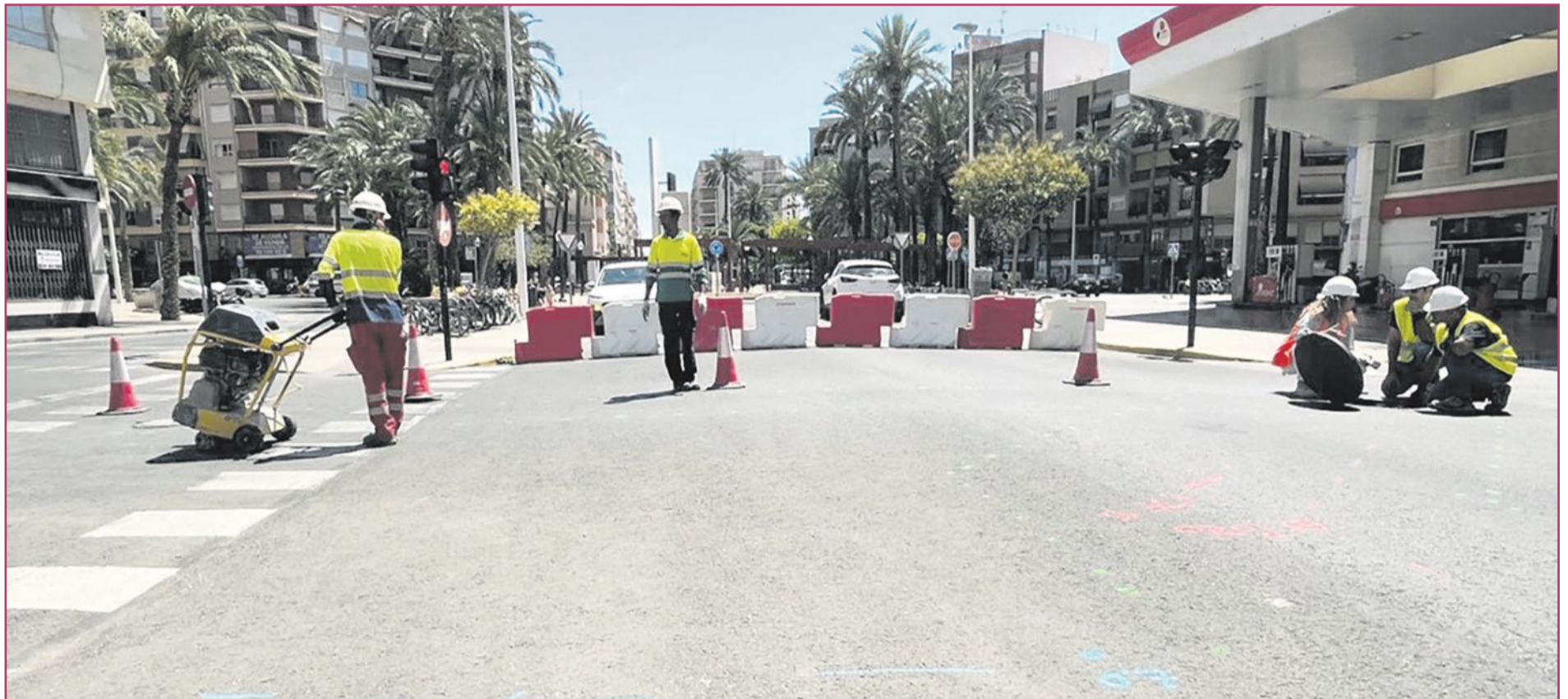
Trabajos de renovación del alcantarillado en la calle Antonio Machado.
