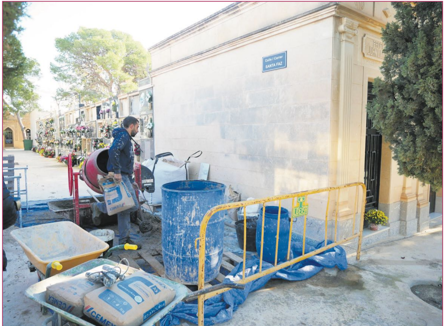
Obras en el cementerio municipal.
