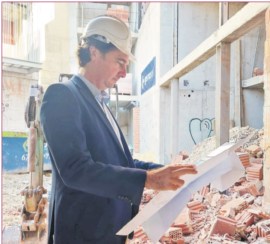
El concejal de Juan supervisa la construcción de viviendas públicas del Portón.
