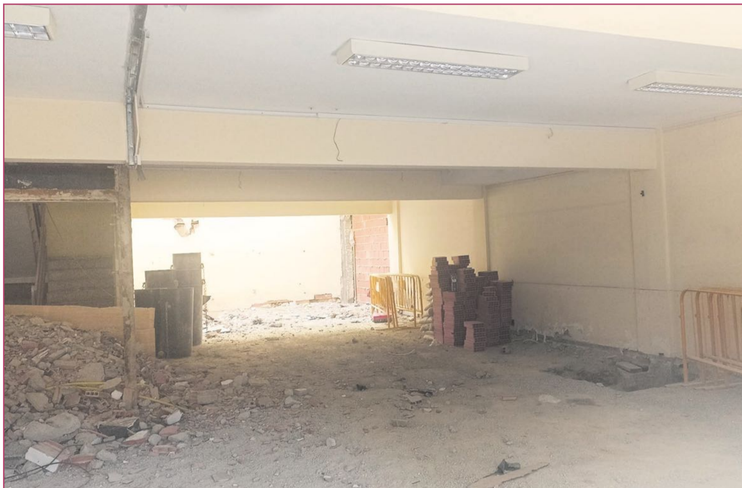
Estado de las obras a finales de marzo.
