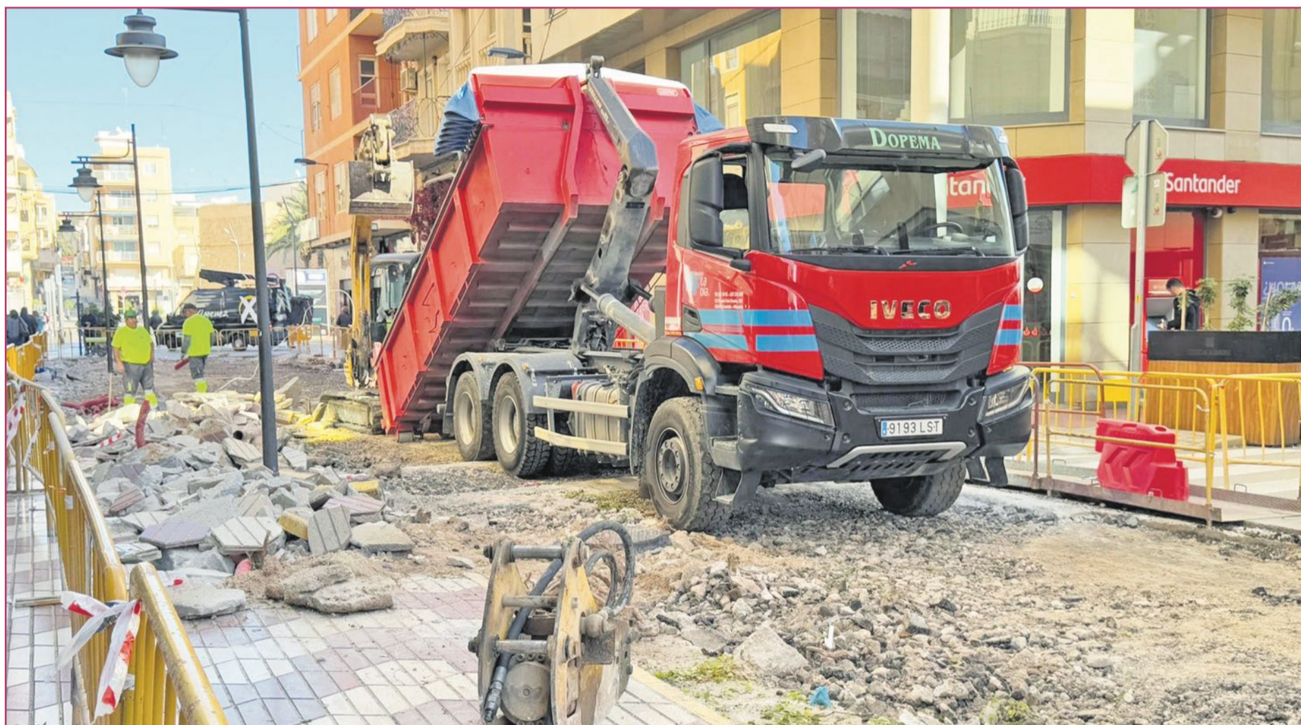
Primeros días de las obras en la calle Muelle.
