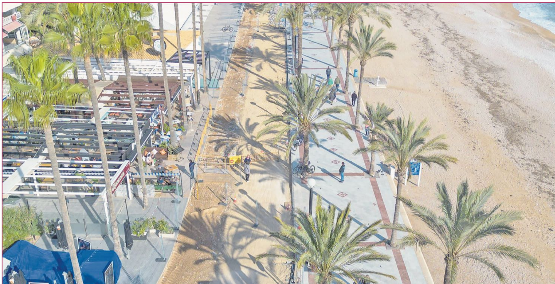
Imagen de parte del Paseo de las Estrellas en obras.
