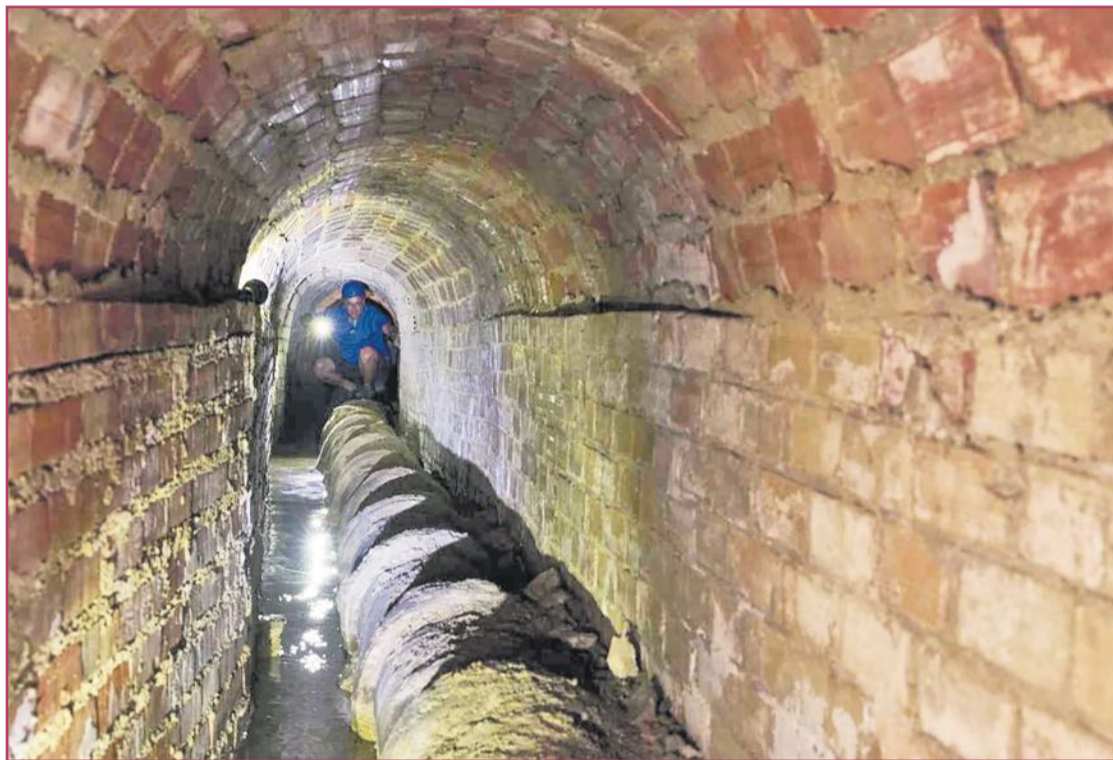
Galería que se pretende recuperar.
