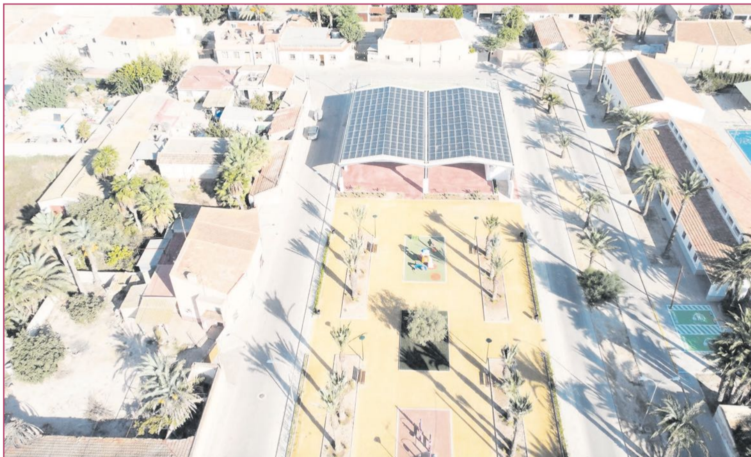
Planta solar de El Realengo.
