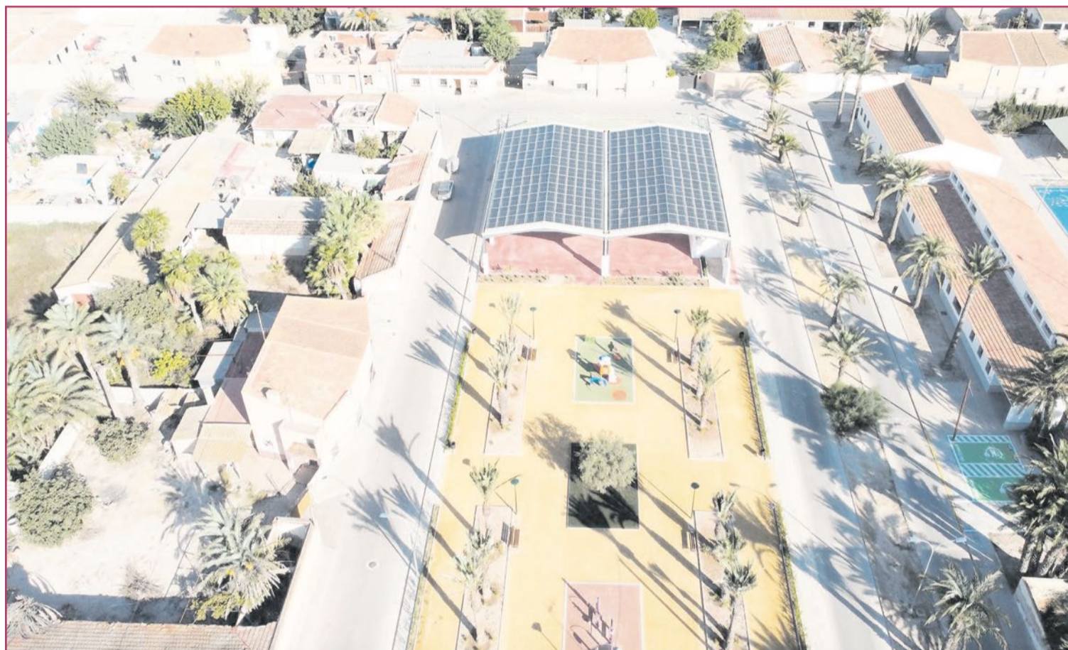
Planta solar de El Realengo.
