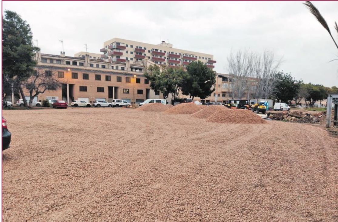
Uno de los solares intervenidos para volver a ser accesibles para el vecindario.
