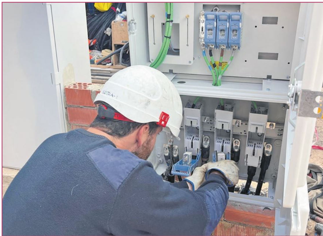
Personal municipal reparando cuadros de luces afectados por la DANA.
