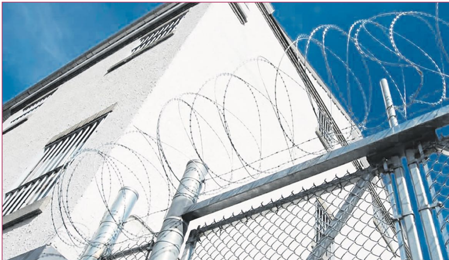
Hospital del centro penitenciario de Fontcalent.
