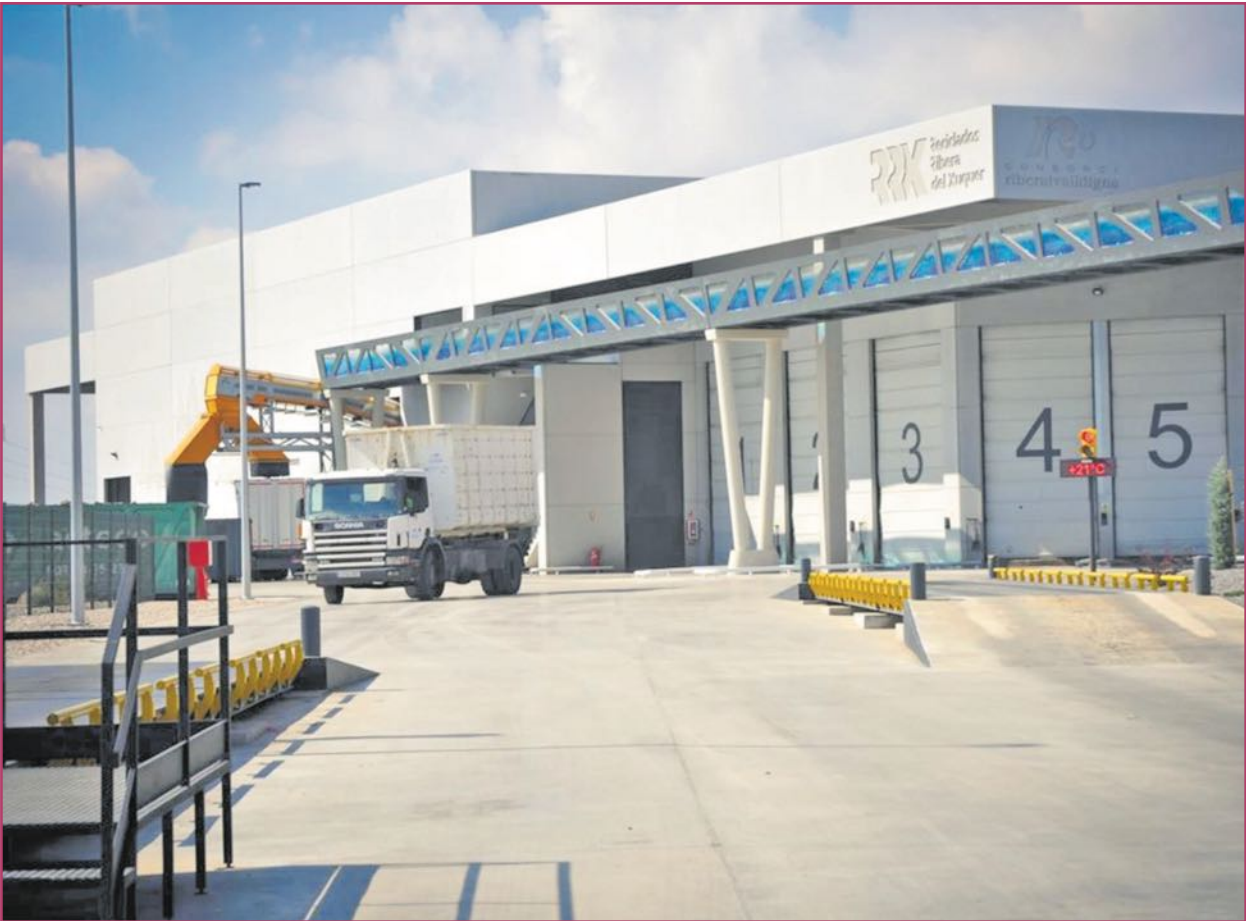
Algunas de las instalaciones de TMB que ya existen en la Comunidad Valenciana.
