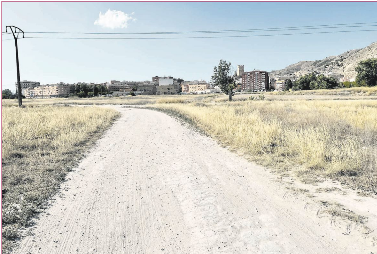
Estado del camino junto a La Hoya.
