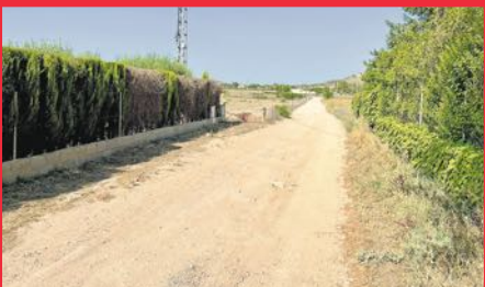
Ambicioso plan de reparación y mejora de caminos rurales, con una inversión de 2,5 millones de euros. Pág. 2
