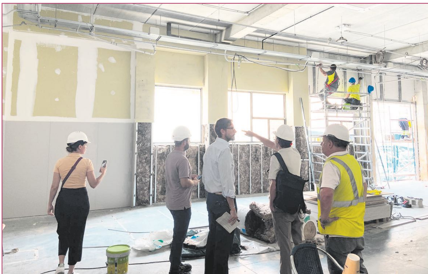
Personal en los trabajos de mejora del IES 25 de abril.
