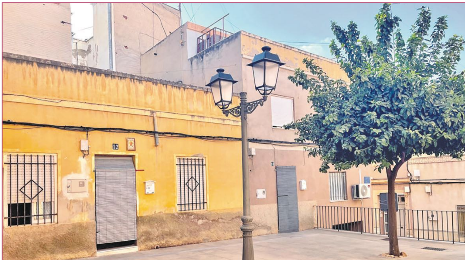
En los barrios antiguos es donde más abundan las viviendas vacías, algunas incluso en estado de deterioro.
