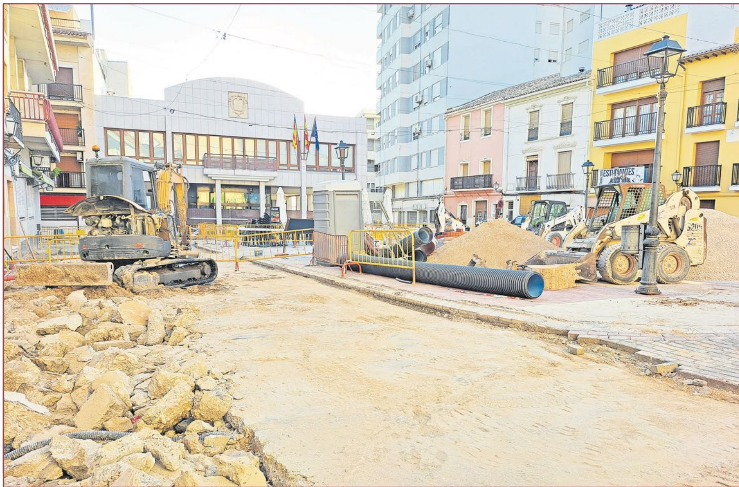
Los trabajos ya están a pleno rendimiento.
