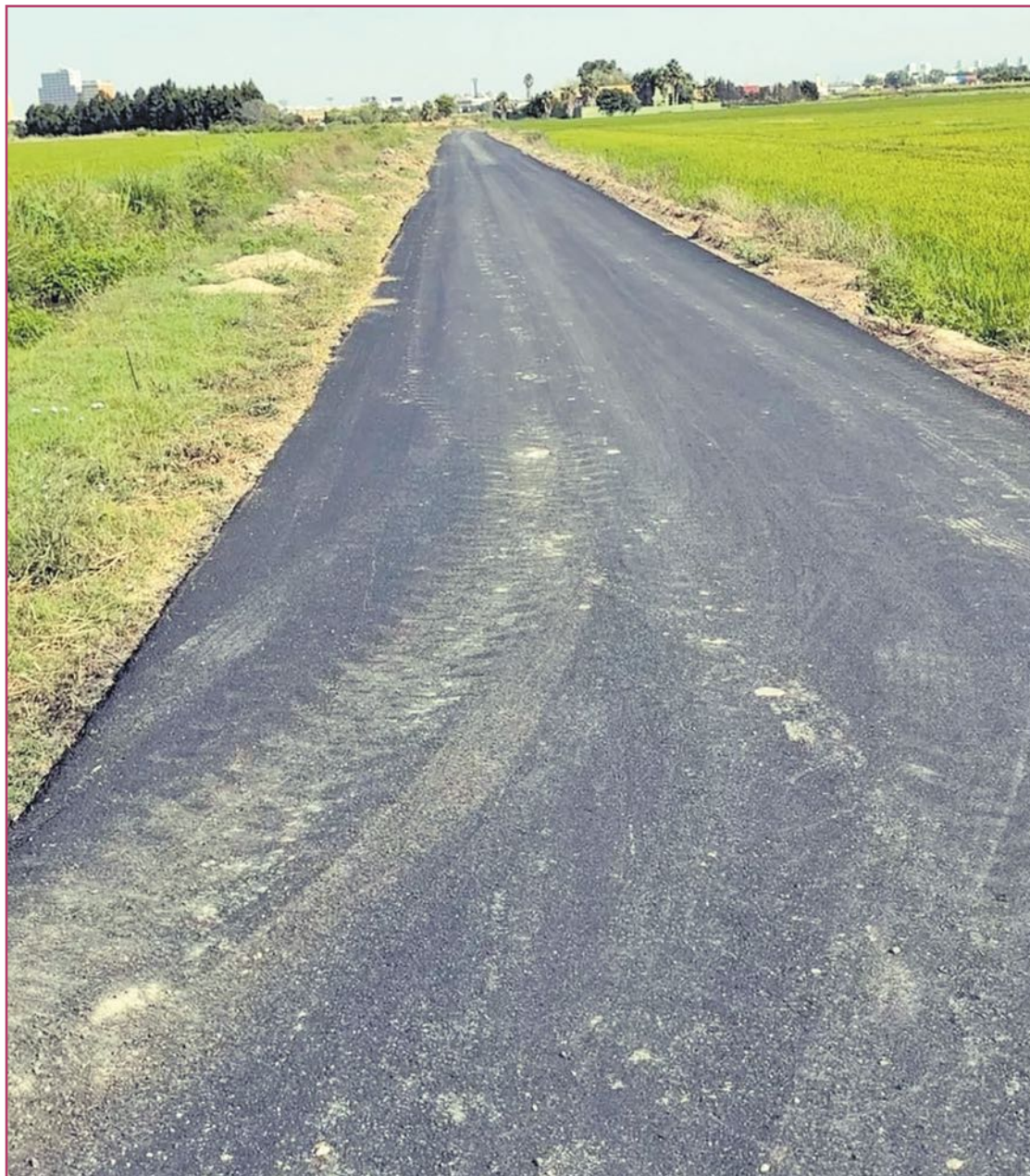
Uno de los caminos rurales reparados.
