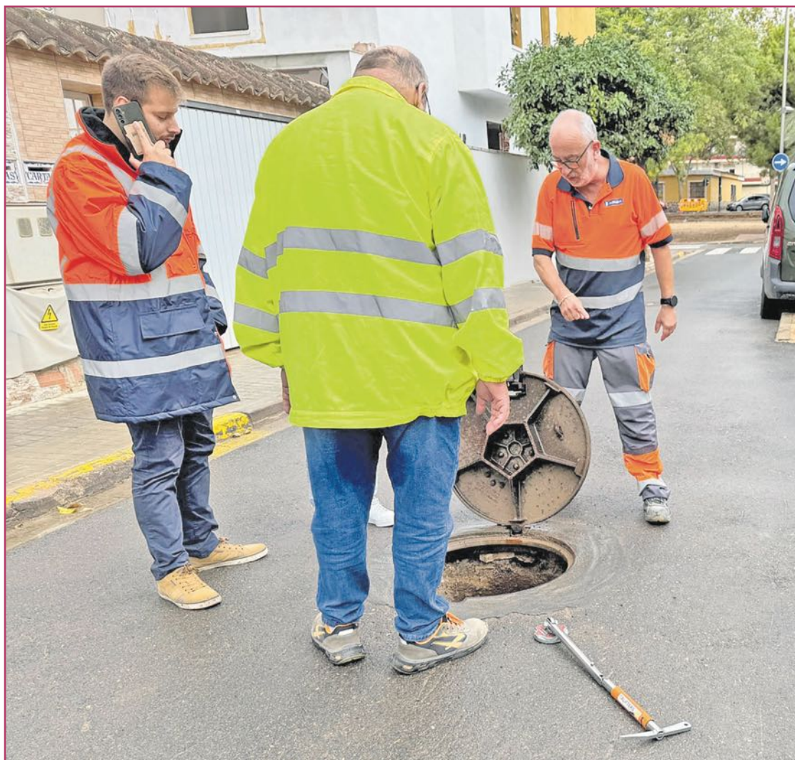
Operarios del Ayuntamiento realizando mantenimiento de la vía pública.
