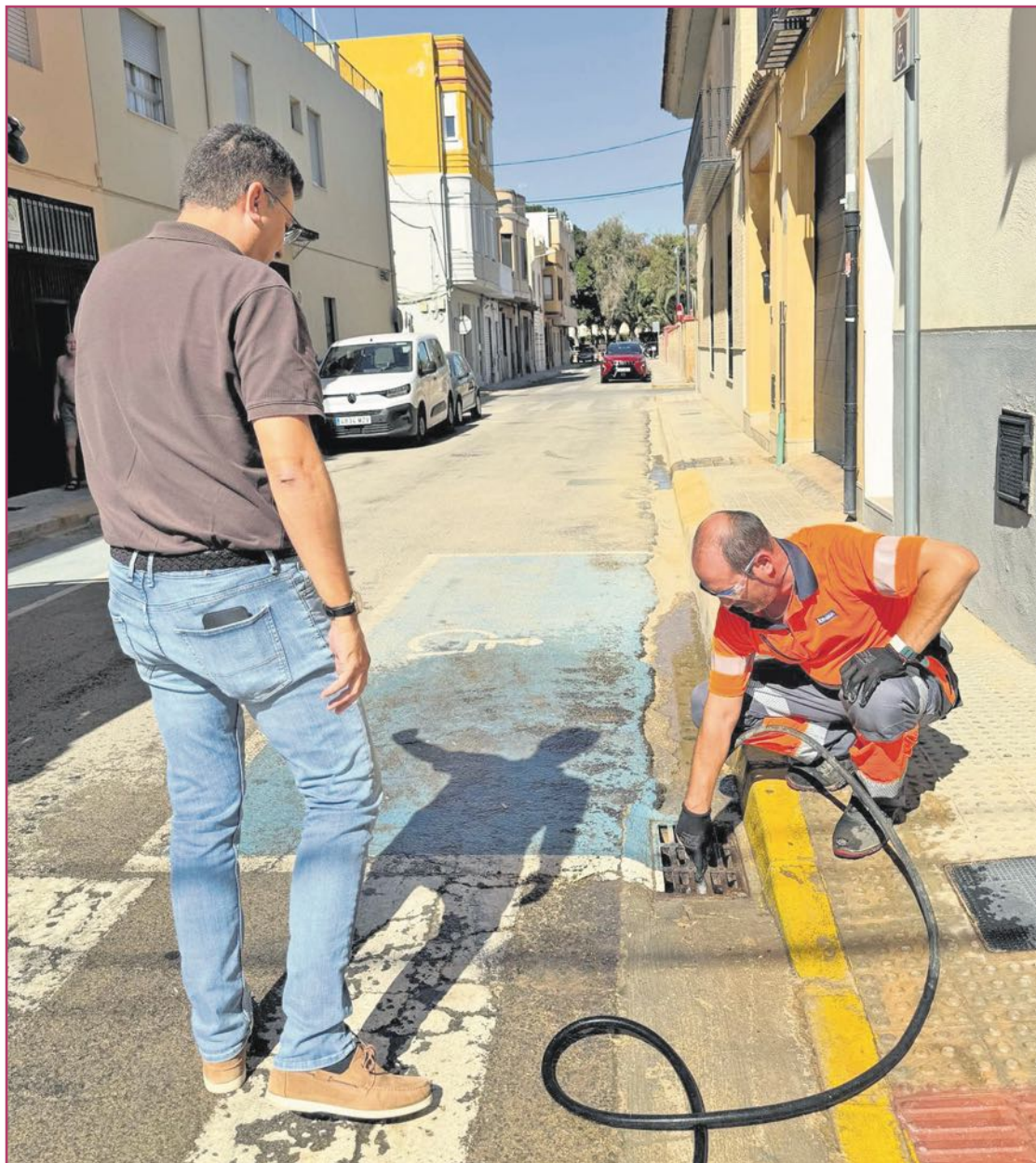
El alcalde de Alfatar, Juan Ramón Adsua, junto a uno de los operarios de Hidraqua durante las labores de mantenimiento de imbornales.
