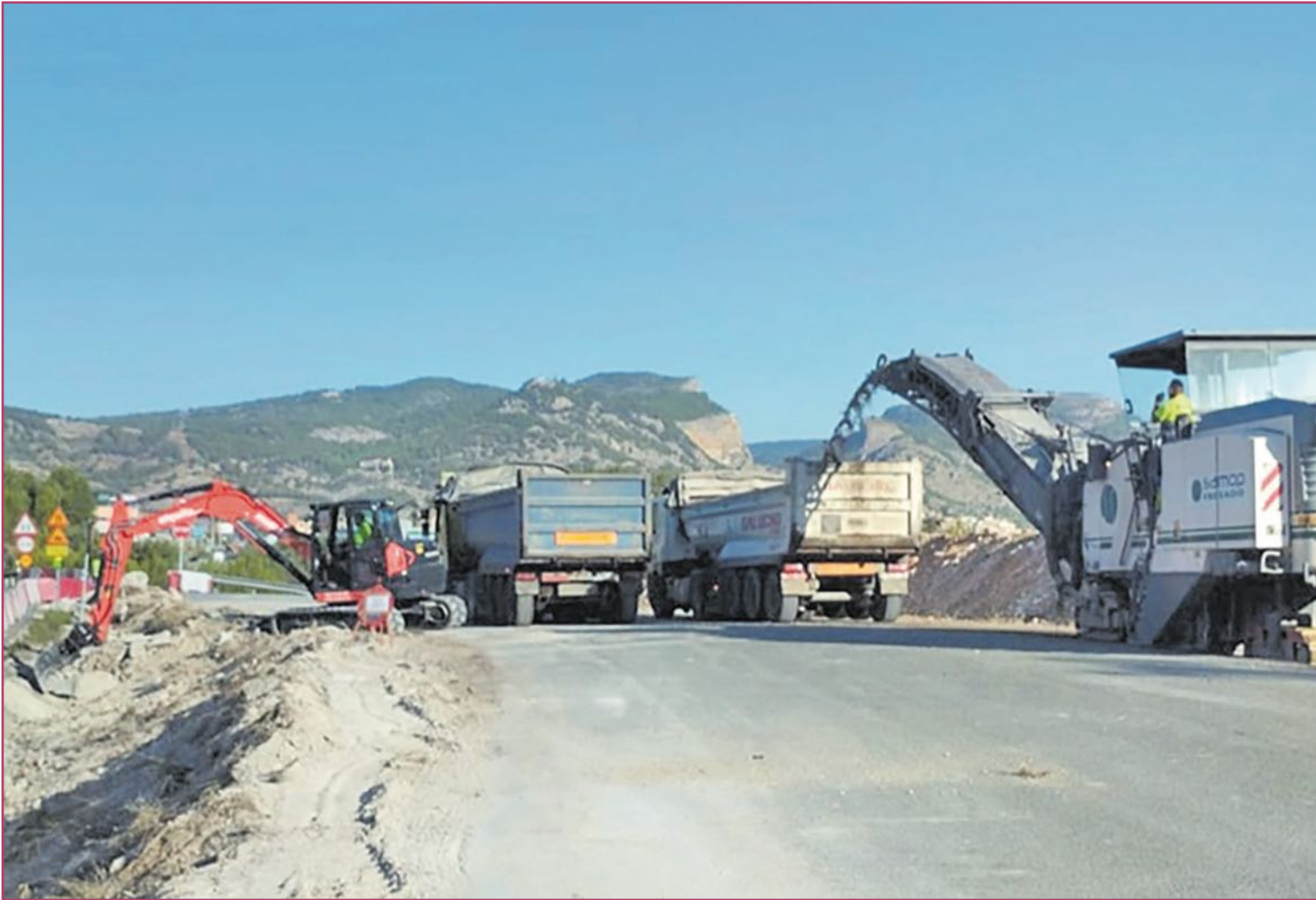
Comienzo de las obras en la N-340.
