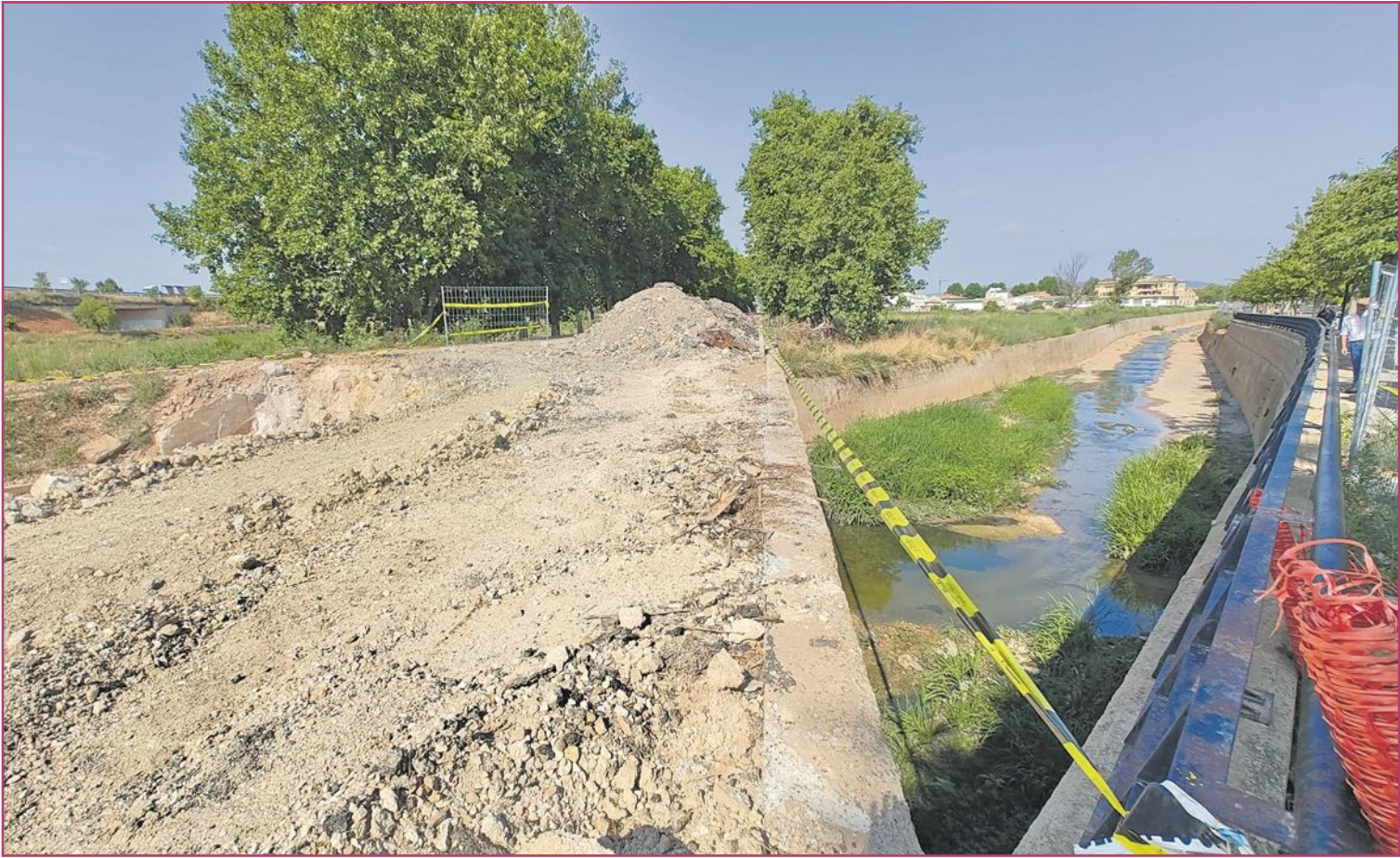
Puente de la N-III.
