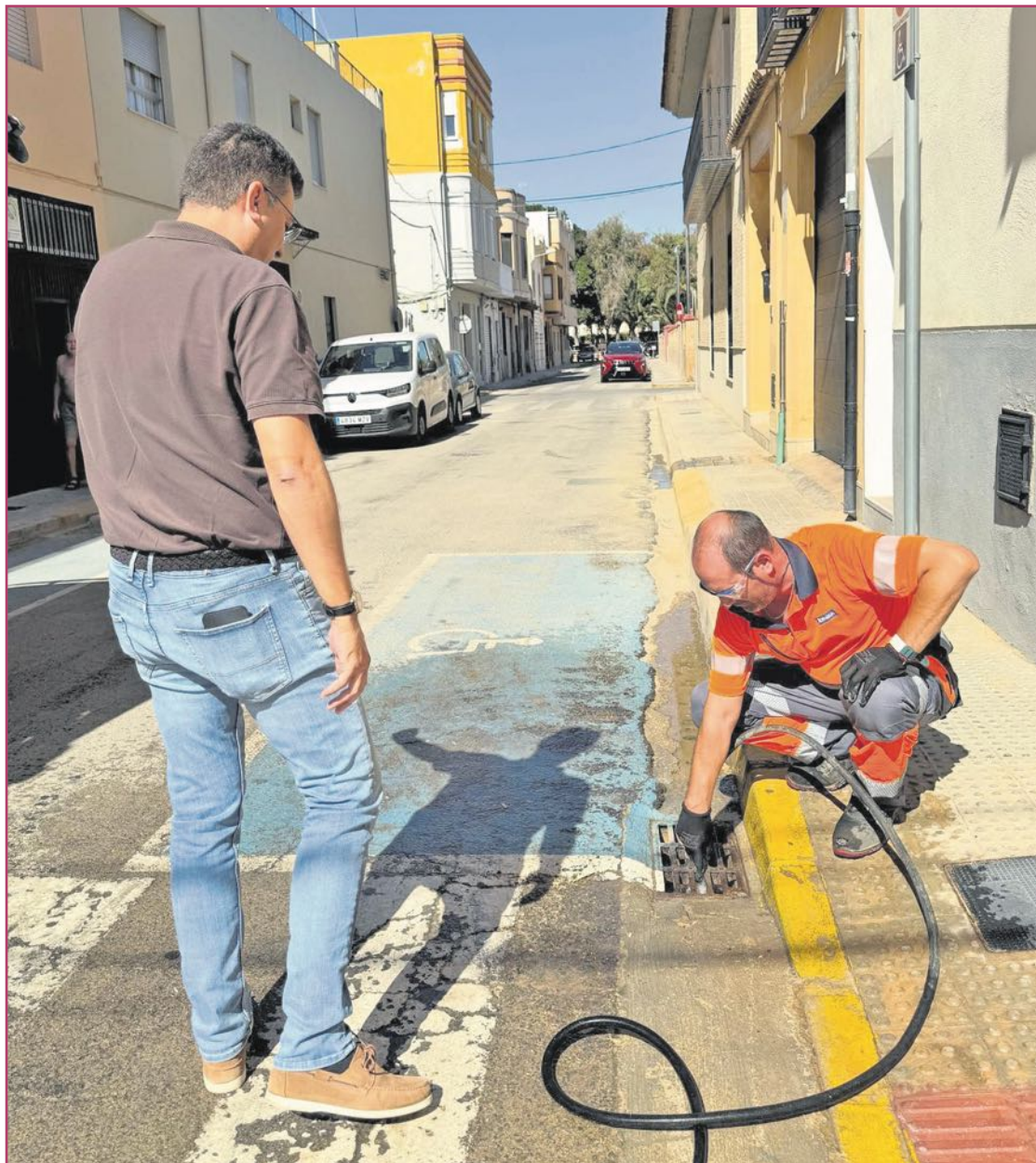
El alcalde de Alfajar, Juan Ramón Adsua, junto a uno de los operarios de Hidraqua durante las labores de mantenimiento de imbornales.
