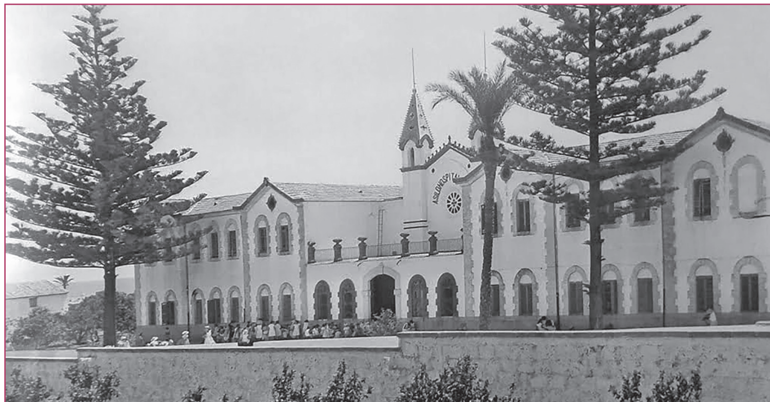
Imagen antigua del Asilo Hermanos Cholbi, el cual mantiene su aspecto en la actualidad.
