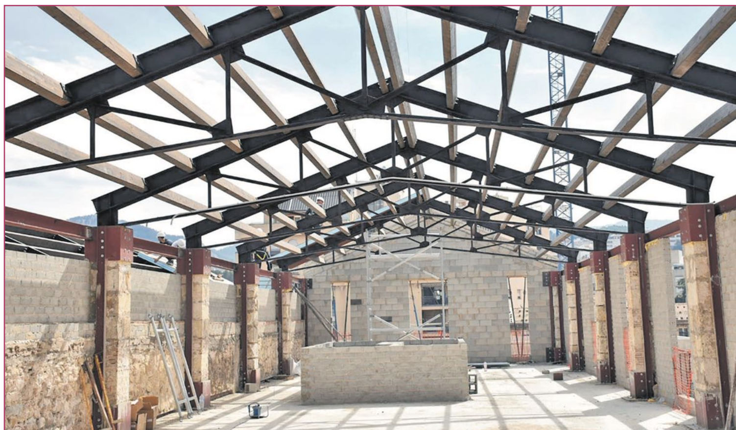
Los Fondos Europeos permitirán culminar las obras en la Fundició Rodes.
