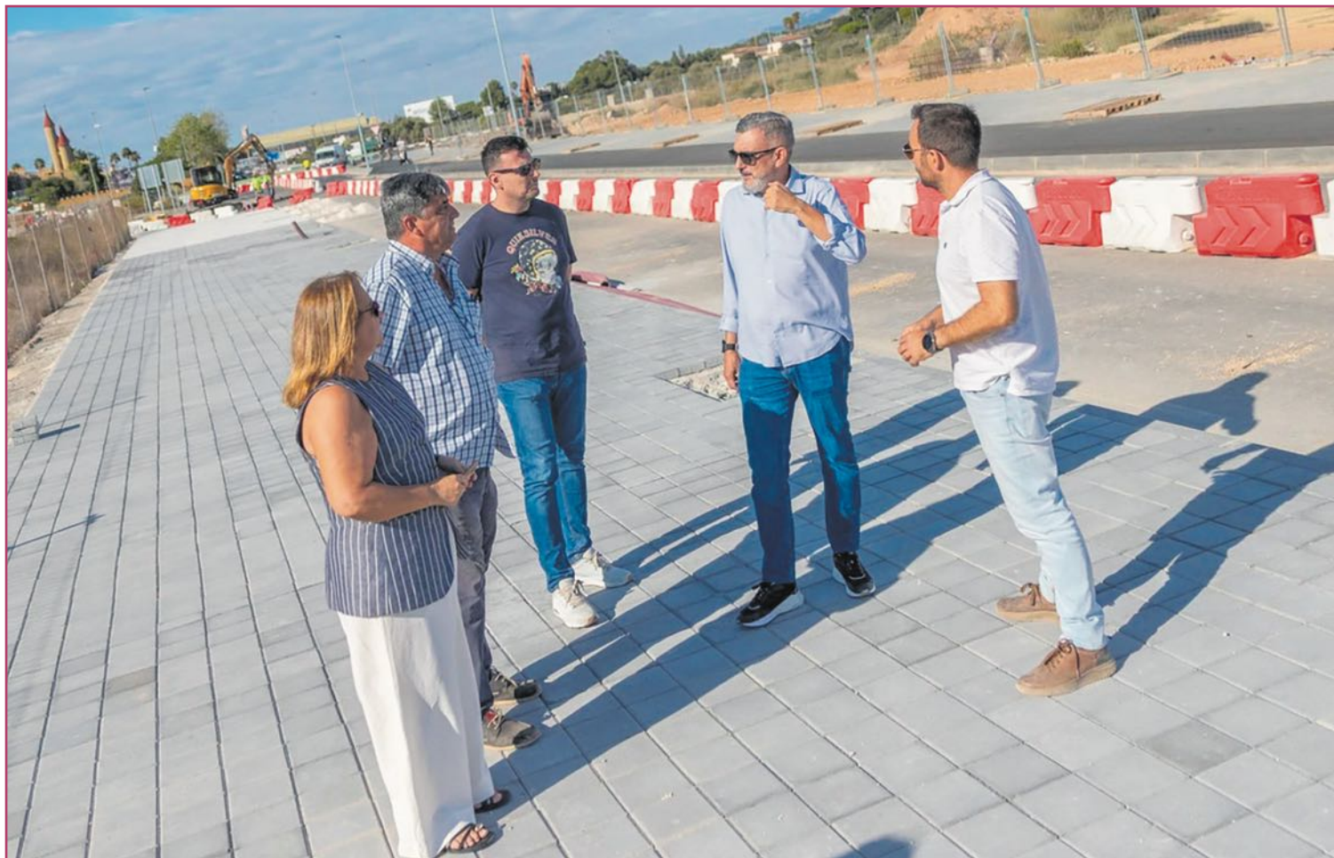
Imagen de una de las últimas visitas a la obra.
