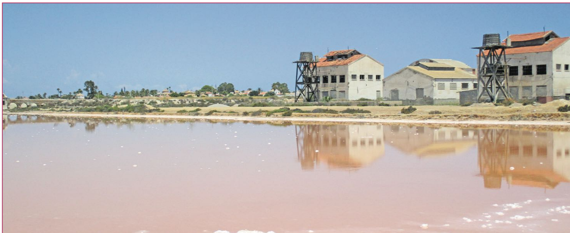
Dependencias de la industria salinera torrevejense.
