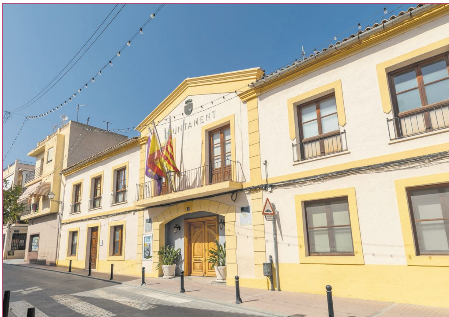
La calle Federico García Lorca quedará completamente renovada.
