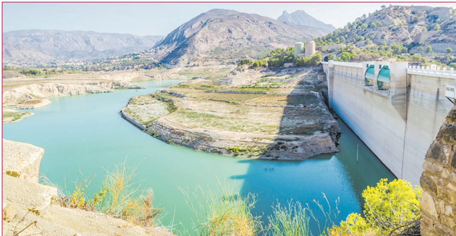
Imagen reciente de la presa del pantano del Amadorio.
