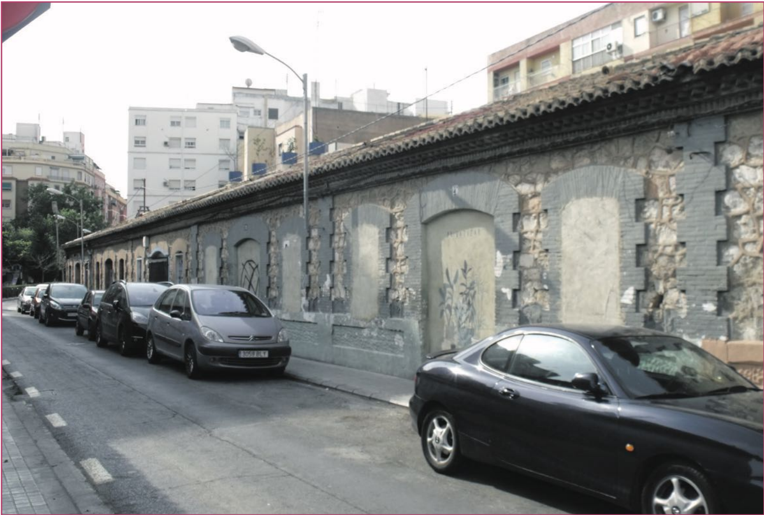
Aparte de conservarse, parte del Barrio Obrero Ramón de Castro se ha convertido, con su protección como Bien Local, en un museo vivo | 19Tarrestnom65
